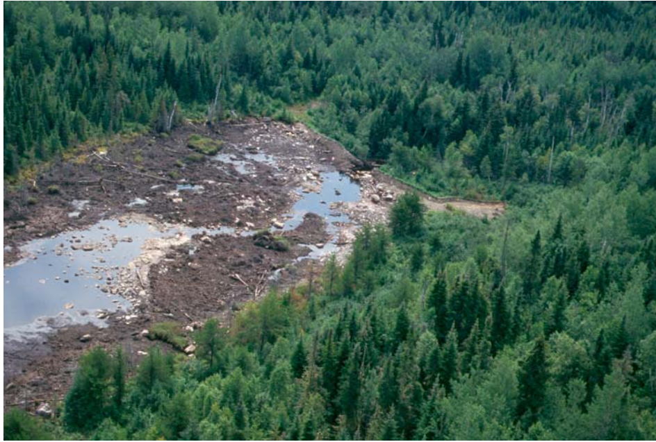
Figure 5. Étang récemment vidé à cause de la rupture du barrage, dans les Laurentides (Photo : André Robitaille)
